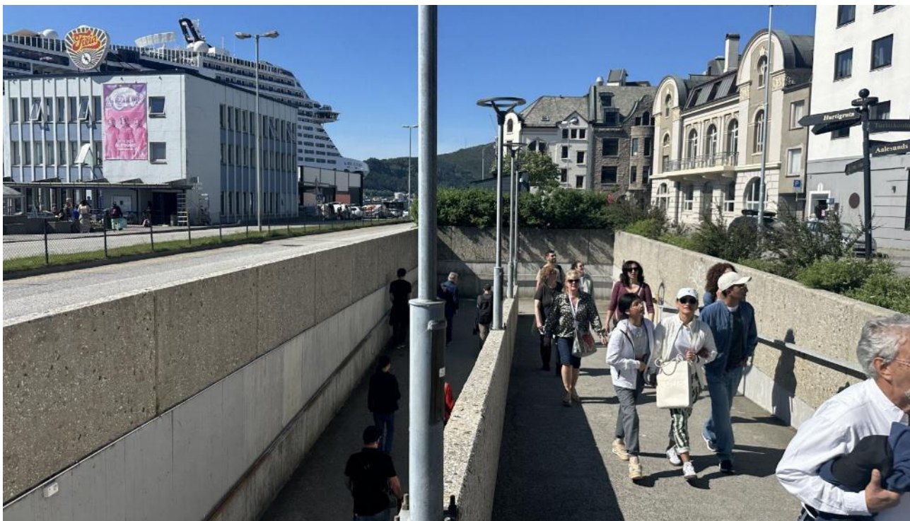
Figur 3-7. Ramper til fotgjengerundergangen sett fra nordsiden av Keiser Wilhelms gate, mot vest.
