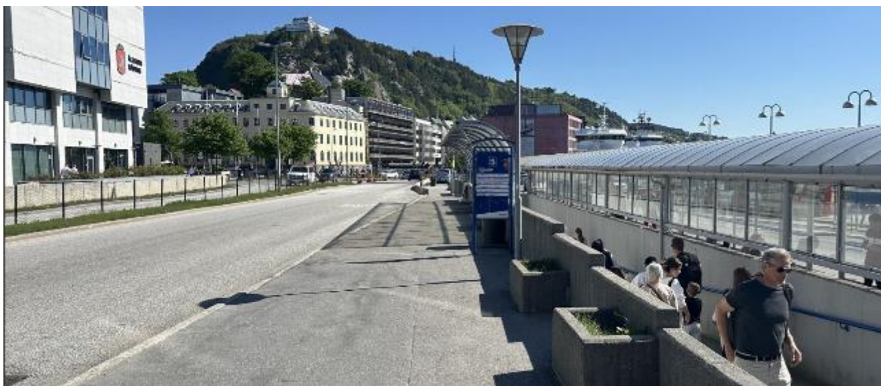
Figur 3-5. Dagens holdeplass sett mot øst, med tilliggende rampe opp fra fotgjengerundergangen.
