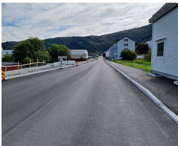
Figur 2: Strekning inkludert i opsjon. Sett fra Tueneskrysset mot Skarbøvika.
