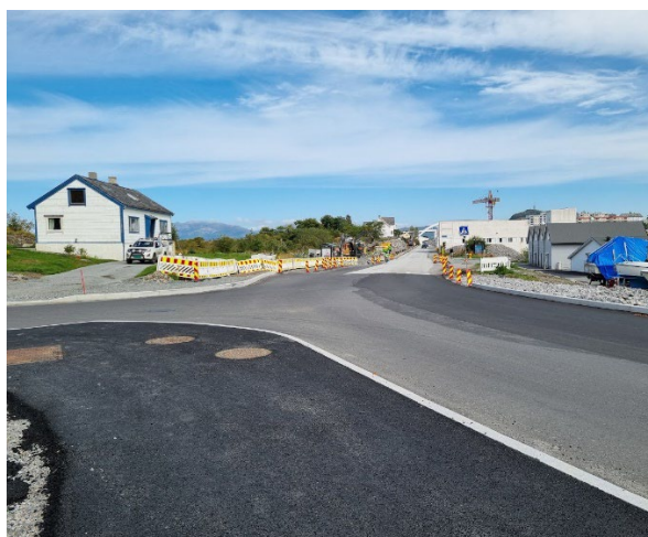
Figur 3: Strekning fra Tueneskrysset mot Steinvågbrua.
