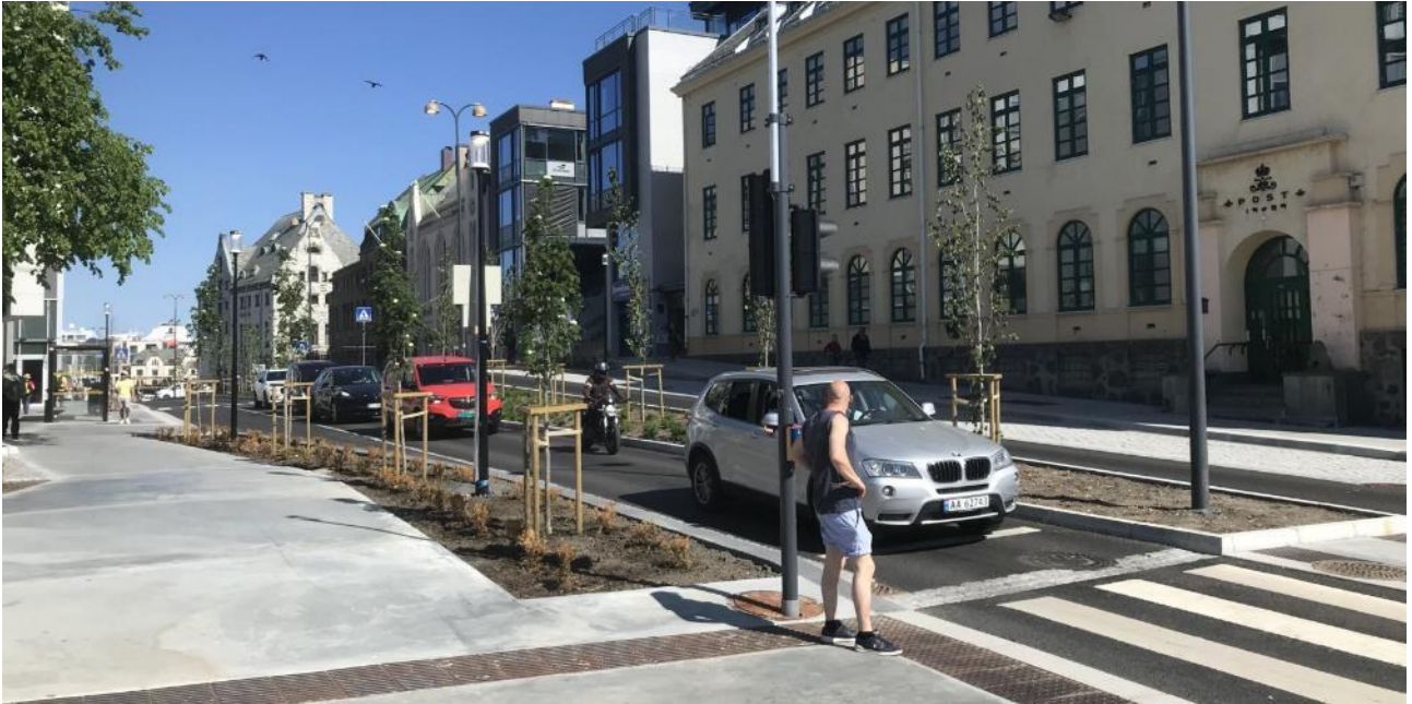
Figur 3-2. Korsegata etter ombygging mai 2024.
