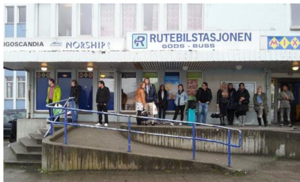
Figur 3-9. Høydeforskjeller på østsiden av Terminalen tas opp med trapper og rampe.
