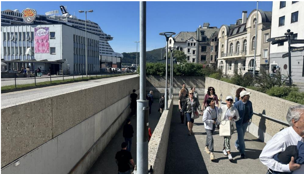
Figur 3-7. Ramper til fotgjengerundergangen sett fra nordsiden av Keiser Wilhelms gate, mot vest.
