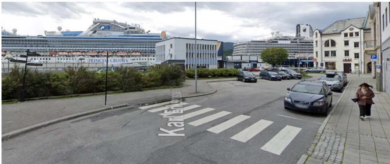
Figur 3-8. Eksisterende fortau på nordsiden av fotgjengerundergangen.
