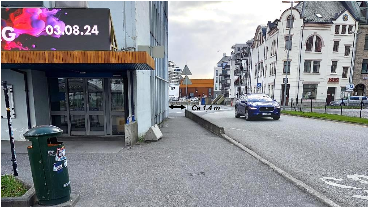
Figur 3-6. Eksisterende fortau vest for holdeplassen er svært smalt, ca 1,4 m på det smaleste.
