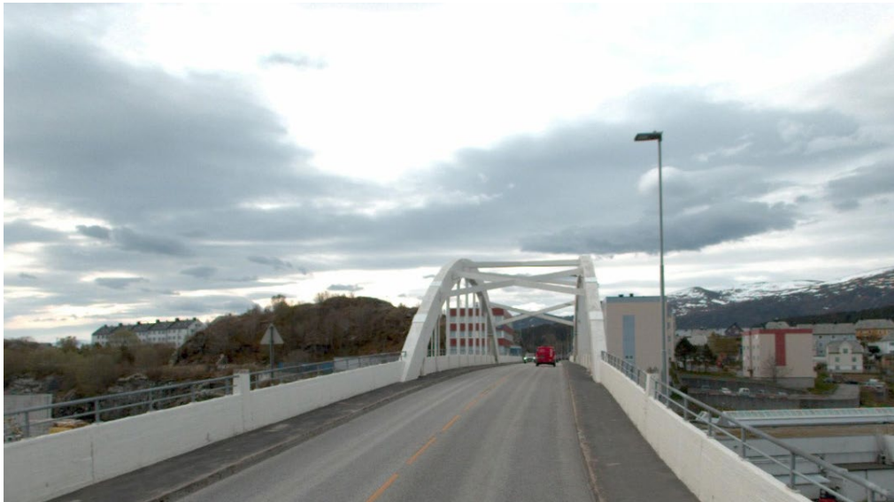
Figur 1: Bilde av Steinvågbrua (Kilde: googlemaps).
