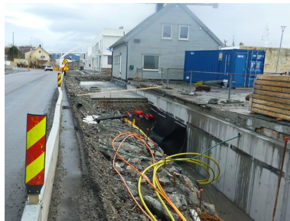
Figur 3 Støttekonstruksjon Tonningsgate sør
